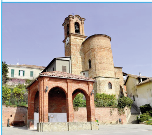
Tetto Peso e pavimentazione
